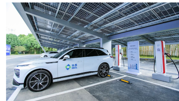
协鑫能源中心内的“光+储+充”能源站，为员工提供“一秒一公里”超充
