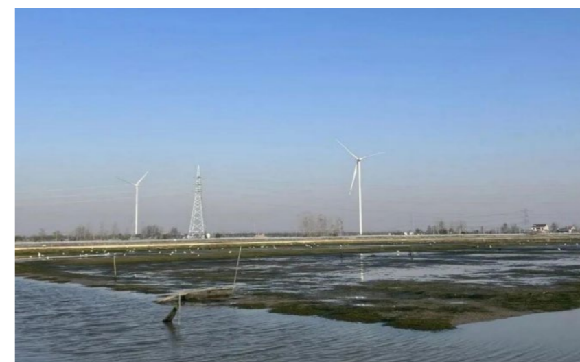
江苏阜宁协鑫 30MW 风电项目
